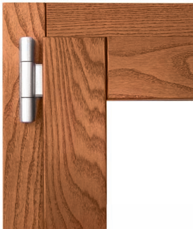
Particolare assemblaggio superiore con taglio a 90°.
