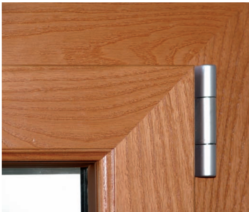
Particolare assemblaggio superiore con taglio a 45°.
